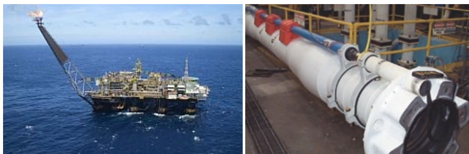
Figura 2 - A esquerda, plataforma P-40, semelhante à plataforma P-17, e a direita, riser fabricado em fibra de carbono.
